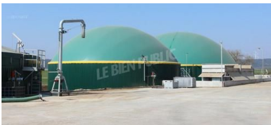
Le digesteur est alimenté chaque jour en vue de la méthanisation. Photo LBP /M. C.
