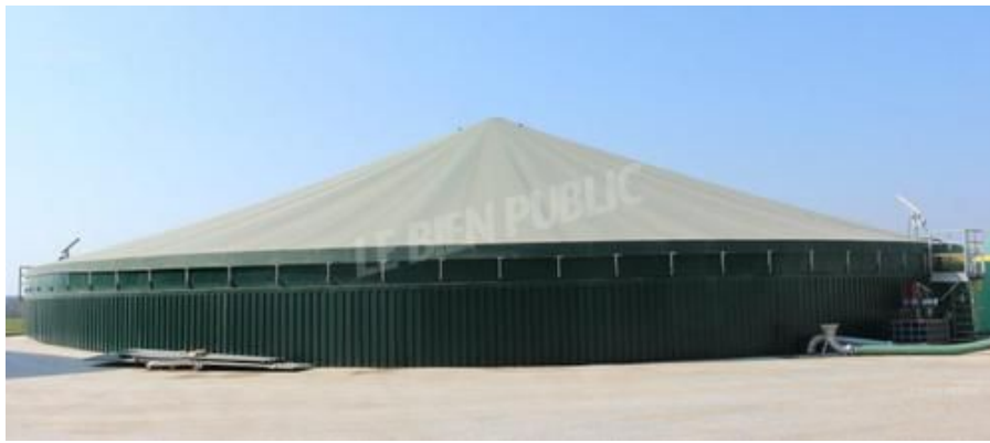
Le digestat, résidu produit par le processus de méthanisation, est stocké dans une cuve de 6 000 m 3 . Il servira ensuite d'engrais organique bio . Photo LBP /M. C.
