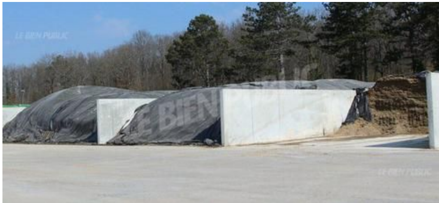
L'ensilage est conservé dans les silos avant d'alimenter le digesteur. Photo LBP /M. C.
