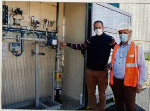
Jean-Charles Collin (à gauche) et François Gaillard, de GRDF, vérifient que le compteur tourne bien. Depuis une heure, le réseau est ouvert et a déjà laissé passer 140 m 3 de gaz. « À la fin du mois, Christophe Monot pourra envoyer sa facture à Engie en inscrivant le nombre du compteur », expliquent-ils. Photo LBP/M. V.
