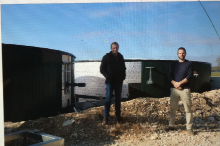
Jérémie Fischer, 34 ans, et Matthieu Besançon, 32 ans, devant l'unité de méthanisation en cours de construction. Photo LB/P.F.S.
