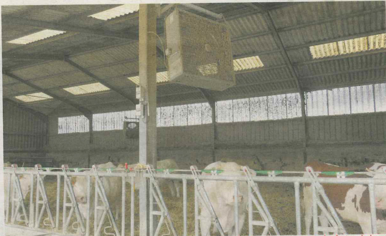
La circulation d'air assurée par les ventilateurs permet aux vaches de bien mieux supporter les fortes chaleurs qui pénalisent leurs performances en engraissement ou en production laitière.
